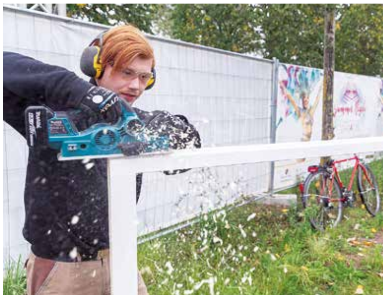
Schreinerei-Mitarbeiter Justin Liepner arbeitet mit dem Hobel noch an einem Türrahmen, um diesen einzupassen
